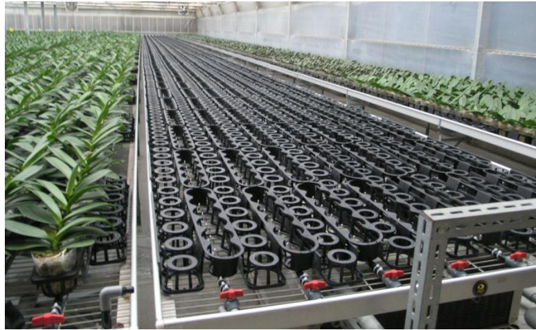
圖2.恆定省水栽培溫室整體系統安裝於合作業界蘭園溫室中。
